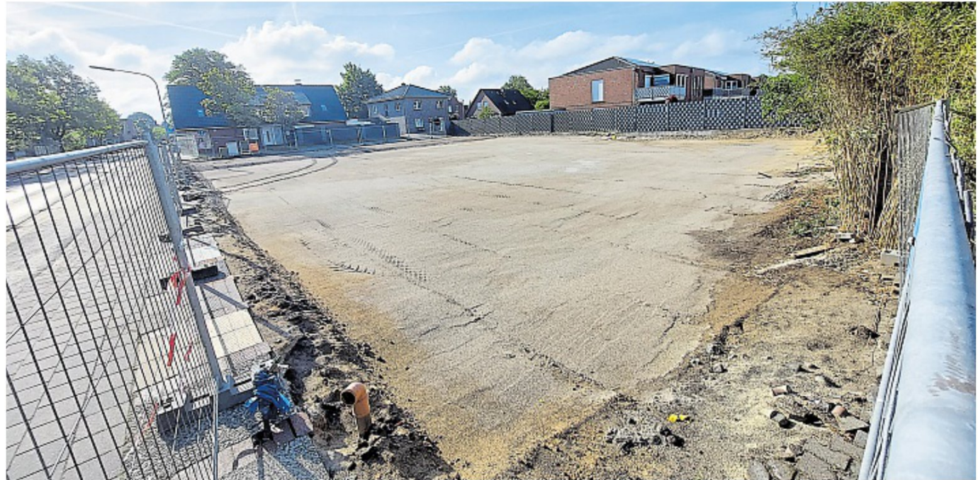
Nach dem Abriss zu Jahresbeginn sind nun die Erdarbeiten für den Neubau am Gasthauskanal angelaufen.
